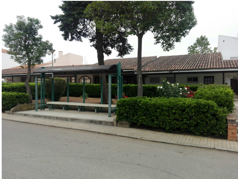
(foto de la parada antes de la obra completa)
