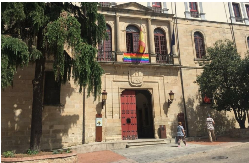
Foto: estado actual.
